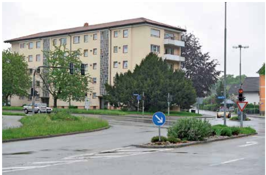
Um die energetische und brandschutztechnische Sanierung des städtischen Mehrfamilienhauses in der Schwarzwaldstraße mit 20 Wohnungen umzusetzen, ist die Beauftragung eines Architekturbüros erforderlich.
